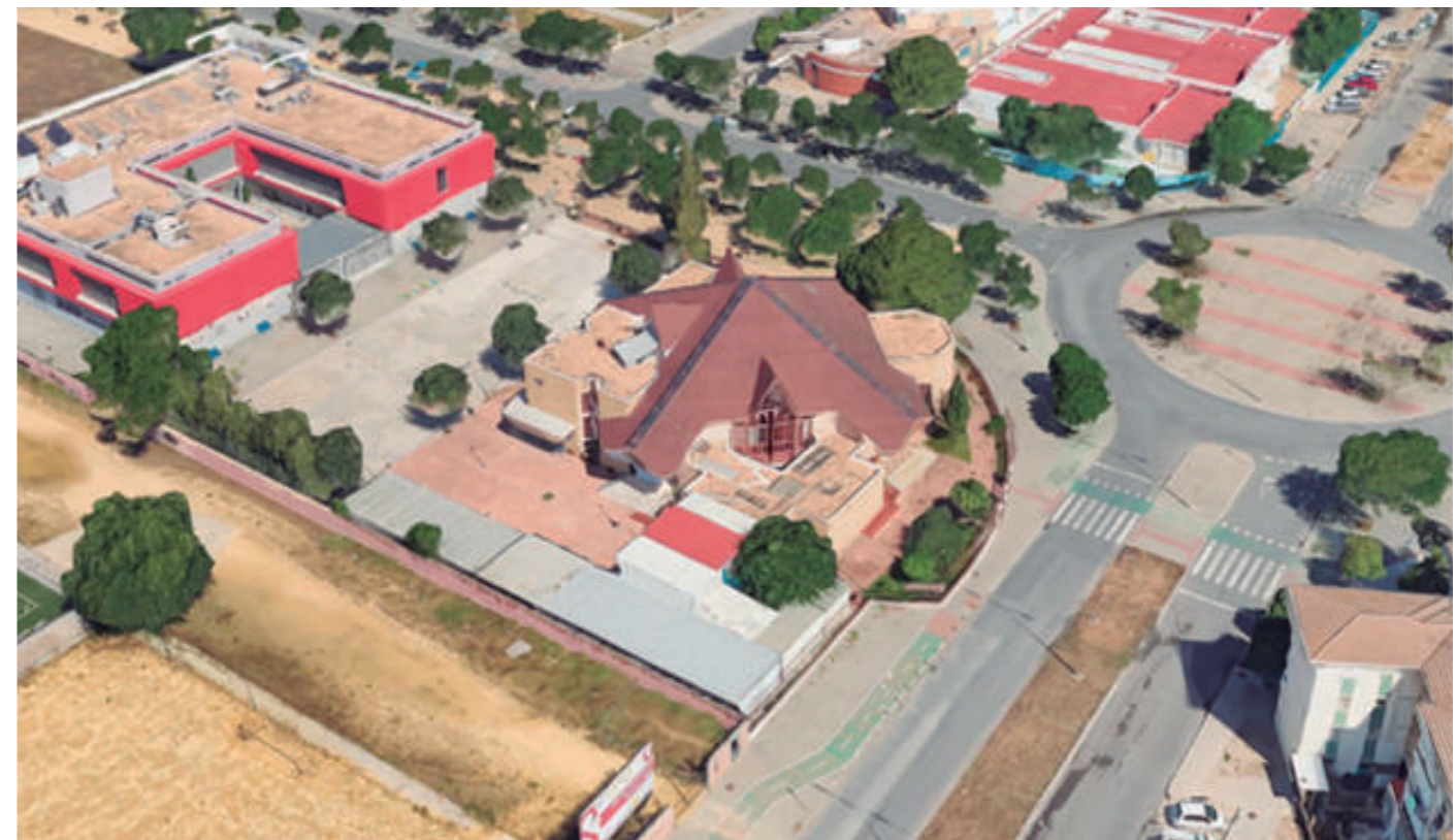
ESTADO ACTUAL. Parcela con construcciones tipo "container" para ubicar dependencias parroquiales y de CÁRITAS
